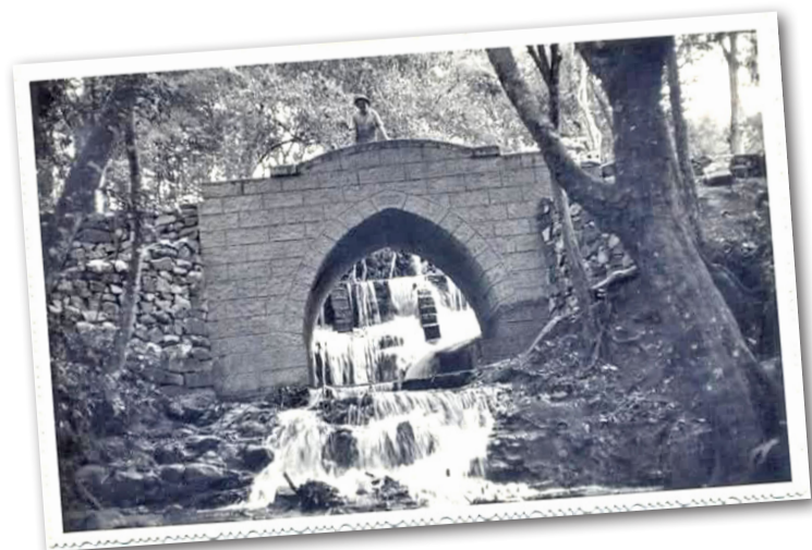
Muro de pedra construído em 1882 foi substituído por um novo em 1959
