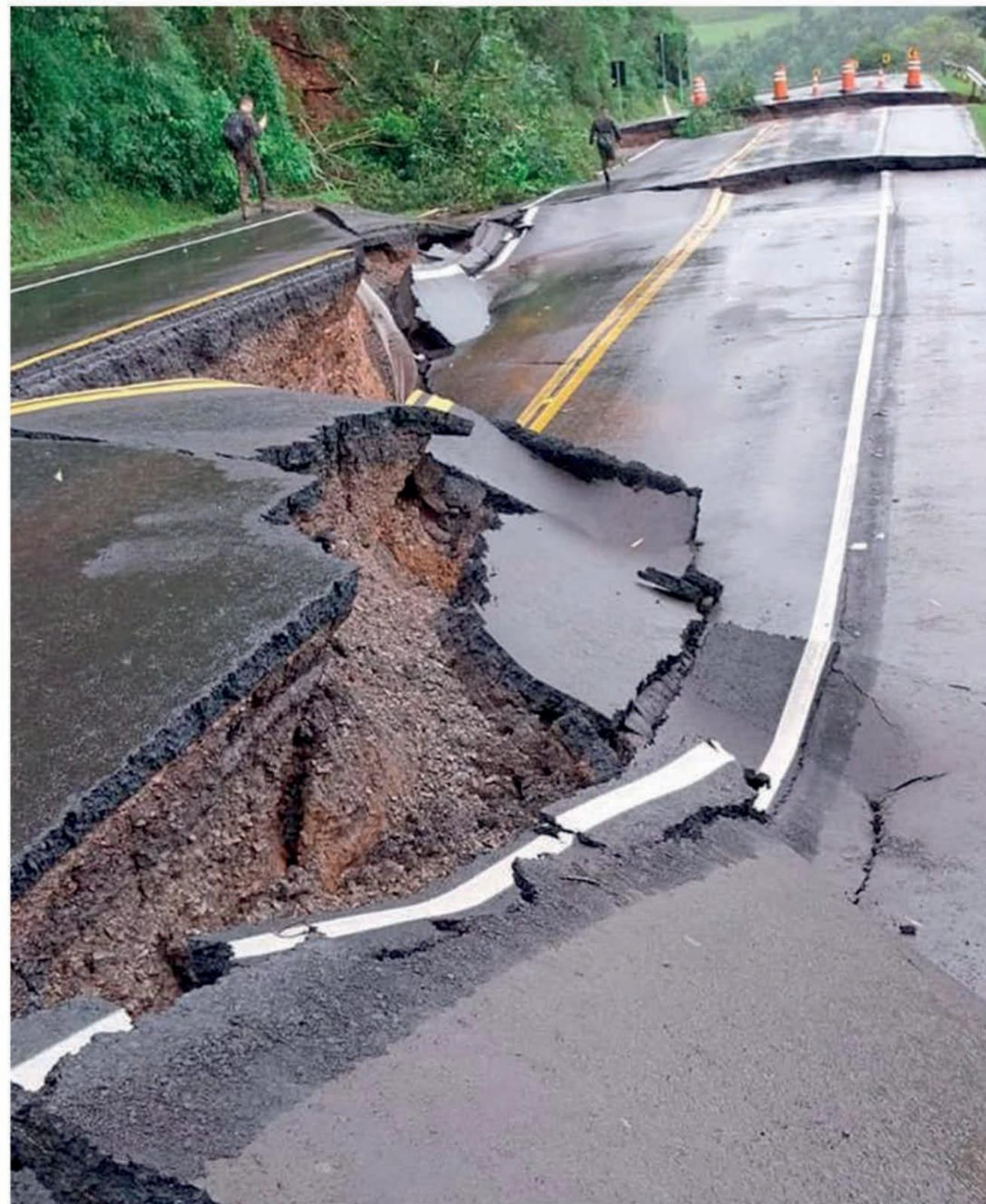
*Em Pouso, rachaduras no solo e desmoronamento tornaram vias interditadas*
