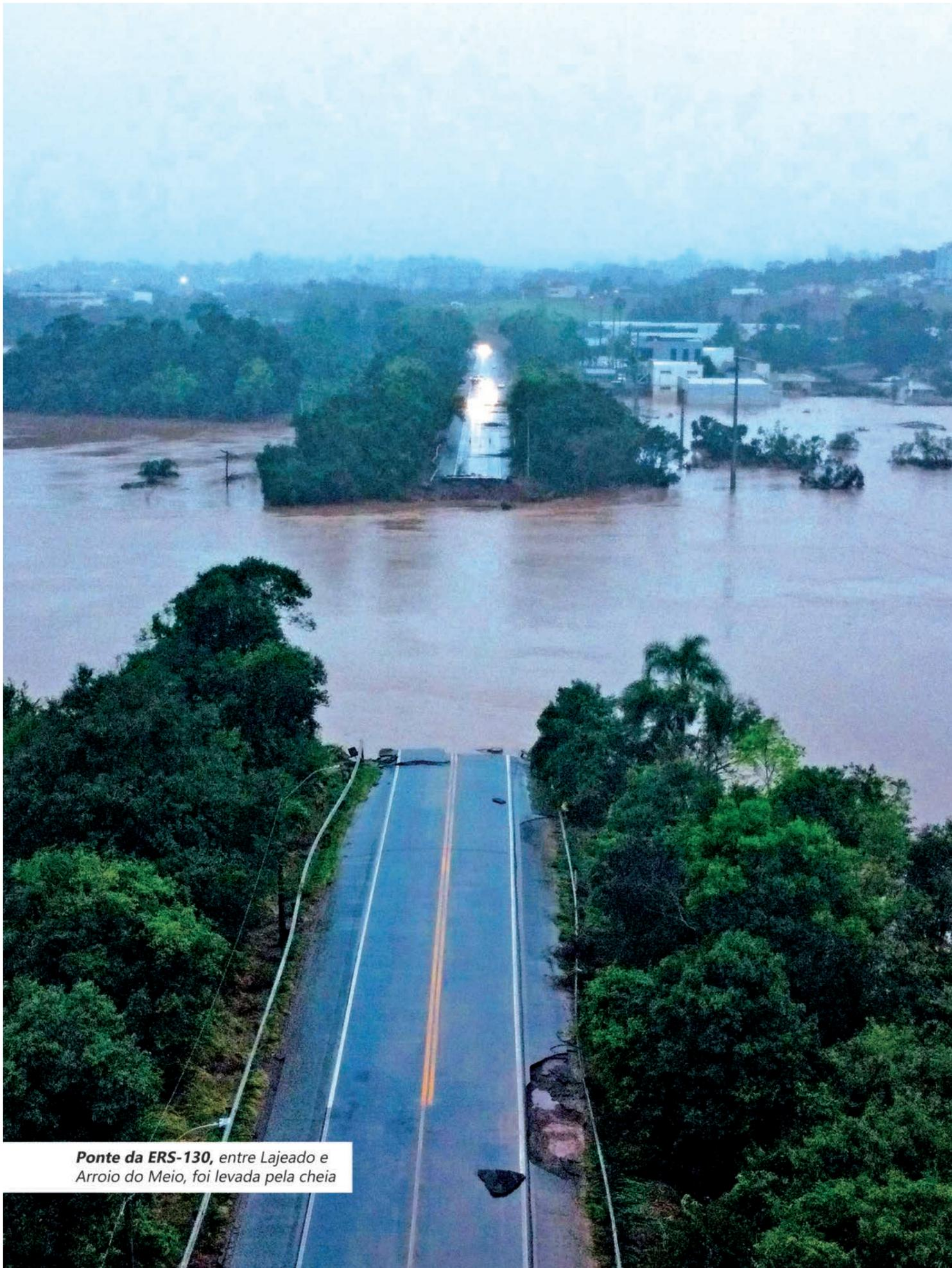
**Ponte da ERS-130, entre Lajeado e Arroio do Meio, foi levada pela cheia**
